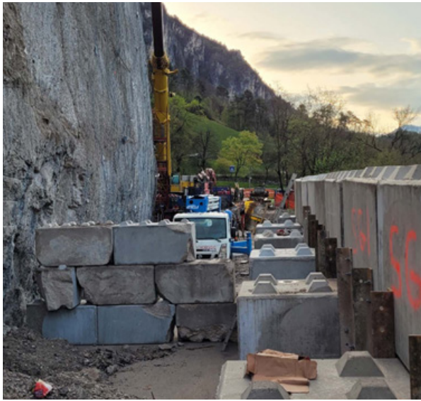
13 aprile - Fine della riprofilazione della parete rocciosa.
