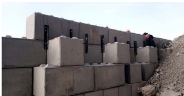
Muro temporaneo di contenimento materiali per innalzamento quota di lavoro.
